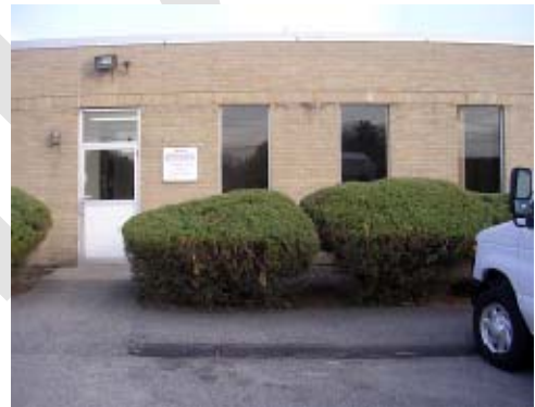
Exterior Wall 4 Egress Door
